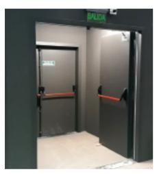
Se adopta el criterio de determinación de manos establecido en la norma IRAM 11505 parte 1. MANO DERECHA, vista en planta, abre con un movimiento de rotación horaria y MANO IZQUIERDA, vista en planta, abre con un movimiento de rotación anti horaria.
